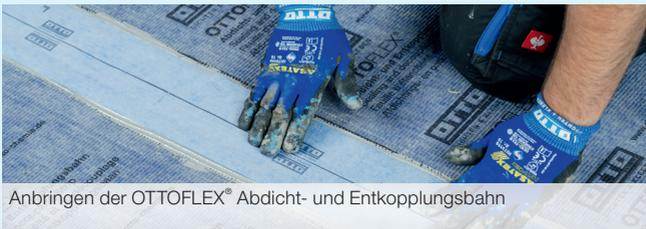
Anbringen der OTTOFLEX® Abdicht- und Entkopplungsbahn
