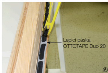
6. Odstranění lineru
