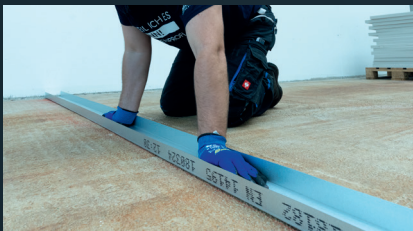
5 Profil ausrichten und andrücken
