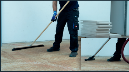
1 Vorbereitung des Untergrundes
