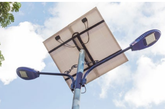
Bild 1 > Mit Solarstrom betriebene Straßenleuchte.
