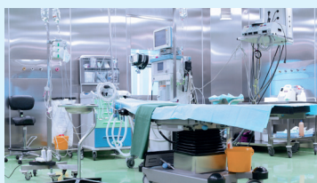
Abdichten von OP-Räumen, medizinischen Untersuchungs- und Laborräumen
