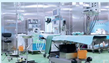
Abdichten von OP-Räumen, medizinischen Untersuchungs- und Laborräumen
