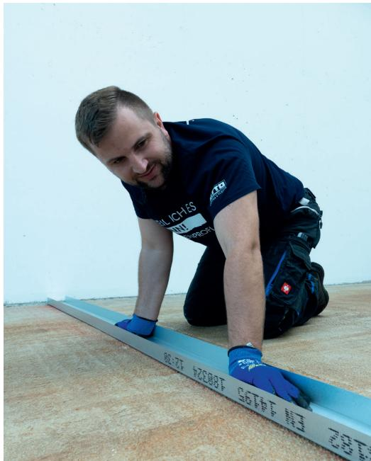
Die Gründe für den Verzicht auf konventionelle Befestigungsmethoden im Trockenbau liegen auf der Hand. Bei der Montage des Ständerwerks mit Schrauben und Dübeln besteht die Gefahr, dass Fußbodenheizung, Leitungen oder Klimadecken beschädigt werden. Oder wenn hochwertige Böden, Fliesen und Hölzer verarbeitet wurden, möchte man diese nicht durch Löcher zerstören.
