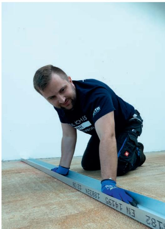
Die Gründe für den Verzicht auf konventionelle Befestigungsmethoden im Trockenbau liegen auf der Hand. Bei der Montage des Ständerwerks mit Schrauben und Dübeln besteht die Gefahr, dass Fußbodenheizung, Leitungen oder Klimadecken beschädigt werden. Oder wenn hochwertige Böden, Fliesen und Hölzer verarbeitet wurden, möchte man diese nicht durch Löcher zerstören.
