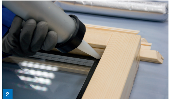
2 Abdichtung am Flügelrahmen hinter der Glashalteleiste
