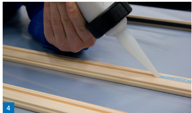
4 Oder: Abdichtung zwischen Flügelrahmen und Glashalteleiste flächig
