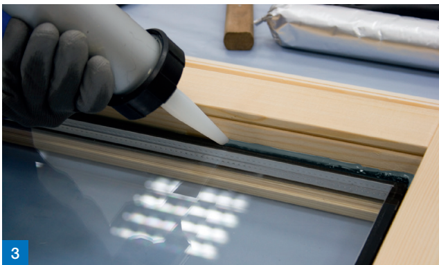
3 Abdichtung zwischen Flügelrahmen und Glashalteleiste auf Position 4
