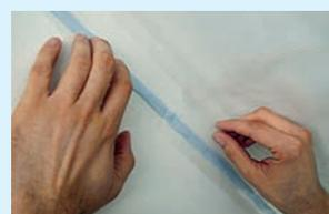
1. Dampfsperre mit Klebeband fixieren. Unmittelbar nach dem Auftragen der **8 mm dicken OTTOCOLL® A 270-Raupe** die fixierte Dampfsperre lösen.
