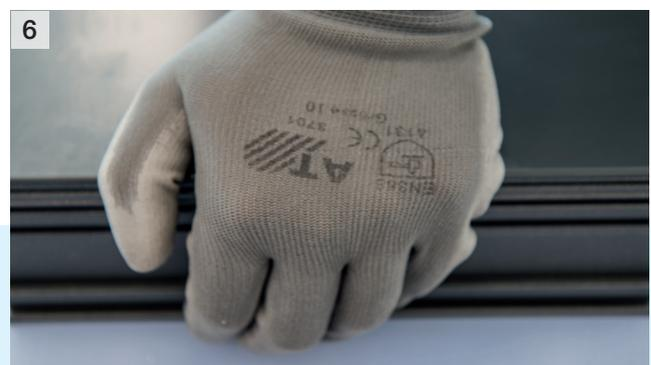
6 Türfüllung von der Mitte nach außen per Hand anpressen – ausreichend Druck für sicheren Kontakt, ohne das OTTOTAPE Fixierband zu komprimieren; Verpressen oder Spannen nicht erforderlich
