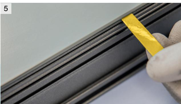
5 Türfüllung zu zweit ausrichten (nicht an Klebeflächen anfassen), dann Liner des OTTOTAPE Fixierbands umlaufend abziehen
