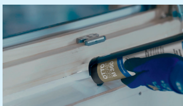
Abdichten von Anschlussfugen an Bauelementen
