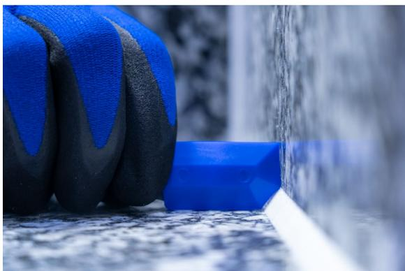
Korrekte Haltung des Glättwerkzeuges
