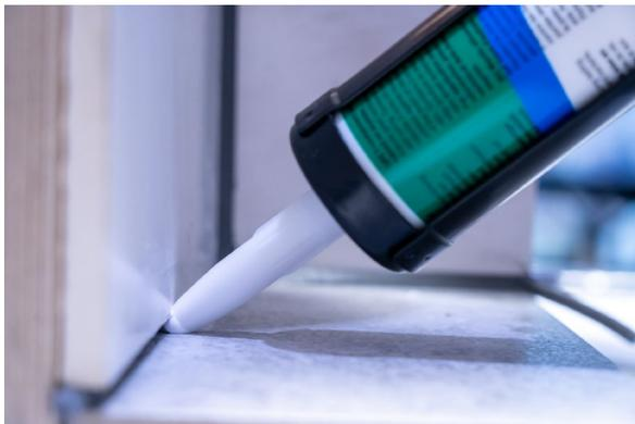
Richtige Dichtstoffmenge in die Fuge einbringen
