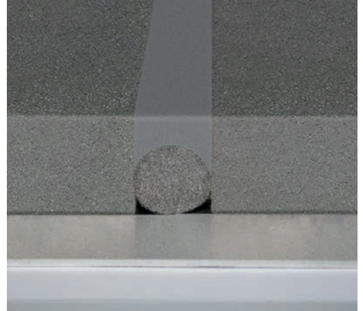
Abdichtung mit Dichtstoff und PE-Rundsnur
