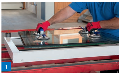
1 Einlegen der Glasscheibe
