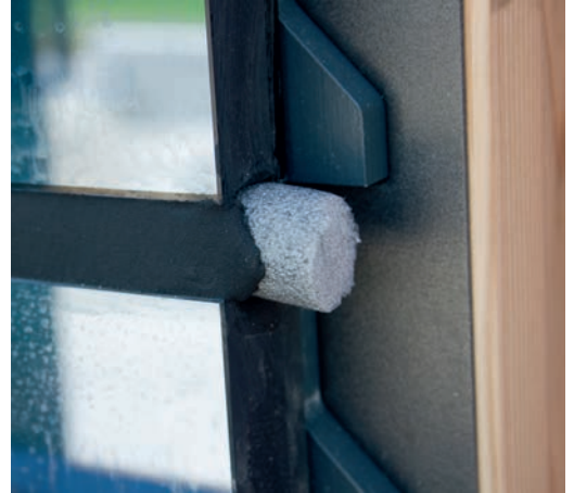
Abdichtung mit Dichtstoff und PE-Rundschnur
