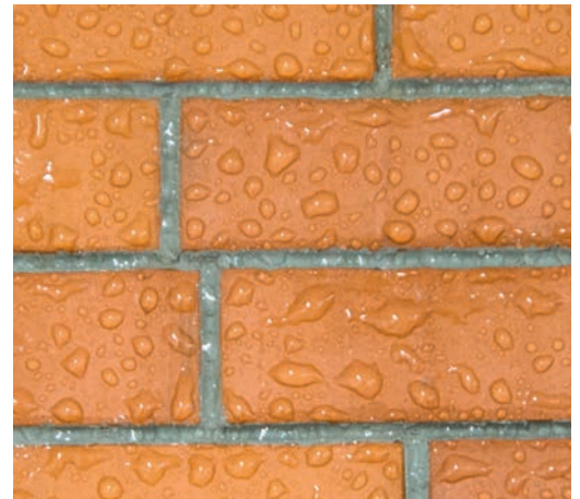
Hydrophobierte Fassade mit OTTO Siloxan 290L
