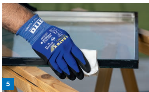
5 Reinigung des Randverbundes mit OTTO Cleanprimer (bzw. Cleaner + Primer) 1) und Stofftuch
