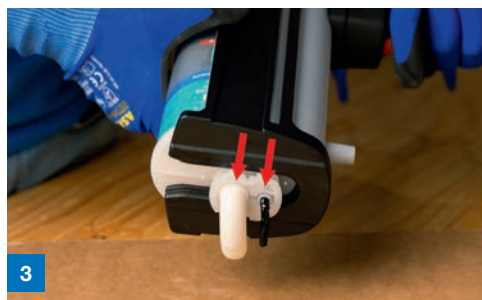
3 Material ohne Statikmischer ausdrücken, bis bei beiden Öffnungen Material austritt
