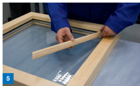
5 Einbringen der Glashalteleiste
