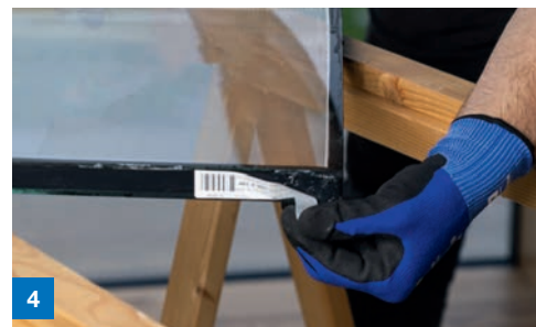
4 Entfernen von Aufklebern vom Isolierglas
