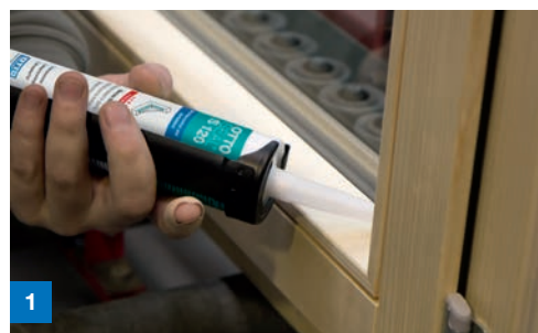
1 Einbringen des Dichtstoffs in den Glasfalz
