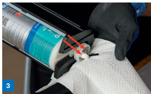
Material ohne Statikmischer ausdrücken, bis bei beiden Öffnungen Material austritt
