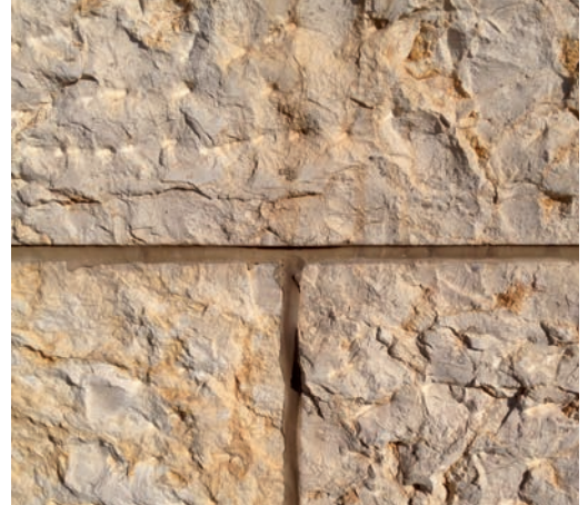
Abdichtung mit Dichtstoff und PE-Rundschnur
