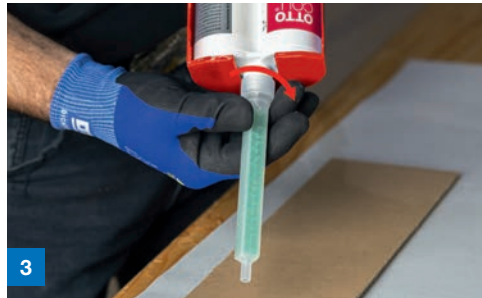
3 Material abwischen und den mitgelieferten Statikmischer MGQ 10-19D aufschrauben
