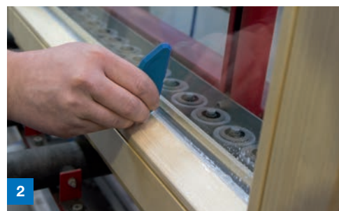
2 Abziehen des Dichtstoffs im Glasfalz mit oder ohne Glättmittel möglich. OTTO Glättmittel im Verhältnis 2:1 mit Wasser mischen. Glättwerkzeug mit dem Gemisch benetzen – diesen Schritt während des Abziehens bei Bedarf wiederholen.
