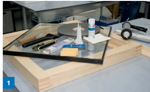
1 Vorbereiten der Abdichtung
