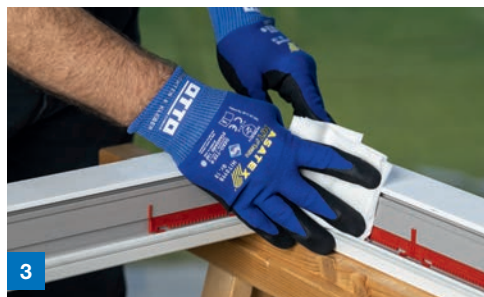
3 Vorbehandlung der Klebfläche des Profils mit OTTO Cleanprimer (bzw. Cleaner + Primer) 1)
