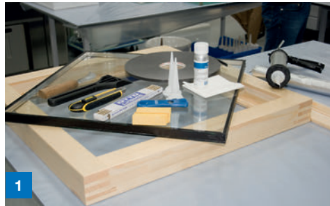
1 Vorbereiten der Abdichtung
