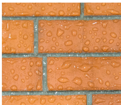
Hydrophobierte Fassade mit OTTO Siloxan 290L
