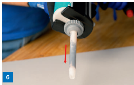
6 Befüllen des Statikmischers mit Klebstoff. Homogenität der Mischung prüfen (siehe Verarbeitungsbegleitende Qualitätskontrollen 2K-Produkte)
