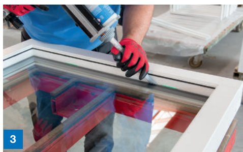
3 Befüllen des Falzgrundes mit Klebstoff
