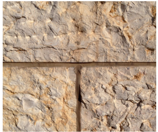
Abdichtung mit Dichtstoff und PE-Rundschnur
