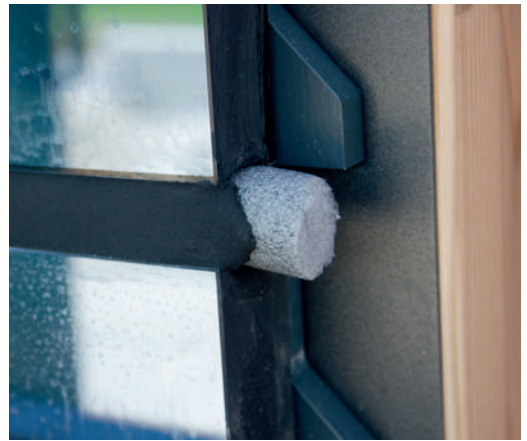
Abdichtung mit Dichtstoff und PE-Rundschnur
