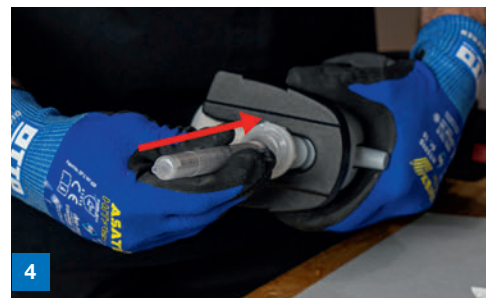
Material abwischen und OTTO Statkmischer ACF ORBIS 12-24X 10:1 aufsetzen
