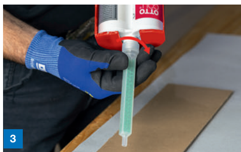
3 Material abwischen und den mitgelieferten Statikmischer MGQ 10-19D aufschrauben
