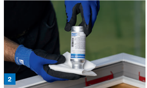
2 Benetzen des Tuches mit OTTO Cleanprimer (bzw. Cleaner + Primer) 1)
