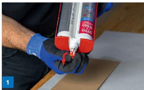
1 Einlegen der Kartusche in die Pistolenschale, Schutzkappe abschrauben und Stopfen entfernen
