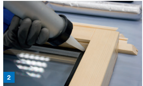
2 Abdichtung am Flügelrahmen hinter der Glashalteleiste
