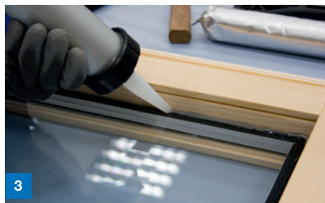
3 Abdichtung zwischen Flügelrahmen und Glashalteleiste auf Position 4
