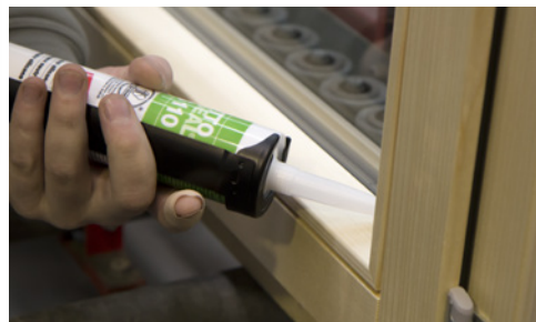
Introduction du mastic dans la feuillure
