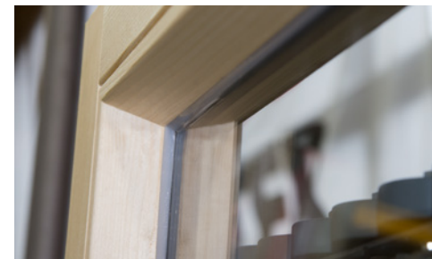
Scellement de feuillures de vitrage fini
