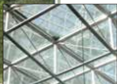
Afdichten van aansluitvoegen in de metaalbouw en afdichten van glaselementen uit VSG en ESG
