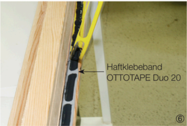
8. Montage der Isolierglasscheibe. Isolierglasscheibe auflegen und mit leichtem gleich- mäßigen Druck auf dem Band fixieren, um den umlaufenden Kontakt zwischen Glasscheibe und Haftklebeband bzw. dem Klebstoff sicherzustellen.
