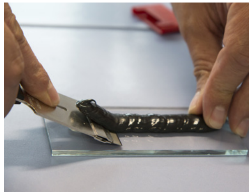
Einschneiden zwischen Klebstoff und Glasscheibe
