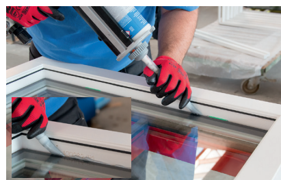
Befüllen des Falzgrundes mit Klebstoff
