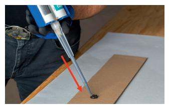
Befüllen des Statikmischers mit Klebstoff und Homogenität der Mischung prüfen (siehe Verarbeitungsbegleitende Qualitätskontrollen 2K-Produkte)
