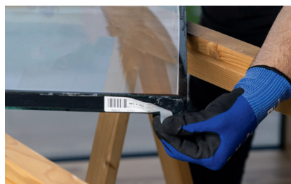
Entfernen von Aufklebern vom Isolierglas
