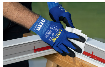
Vorbehandlung der Klebfläche des Profils mit OTTO Cleanprimer (bzw. Cleaner + Primer) 1)
