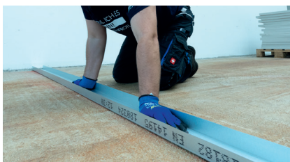
5 Profil ausrichten und andrücken
