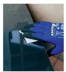
Osnovni uvjet za lijepljenje OTTOCOLL® M 595 je nosivost površine zida. Nosivost se može smanjiti na upijajućim površinama kao što su:B. porobeton – također se može postići prethodnom obradom OTTOFLEX® Deep Primer-a. U sanitarnim prostorima moguće je lijepljenje izravno na OTTOFLEX® tekući film. Osnovni uvjet za dobro prianjanje je površina bez masti i prašine na materijalima koji se lijepe, što između ostalog može se postići čišćenjem OTTO Cleaner T.
