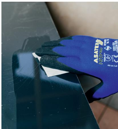
Основною передумовою для склеювання OTTOCOLL® M 595 є несуча здатність поверхні стіни. Вантажопідйомність також може бути досягнута абсорбуючими субстратами - такими як газобетон - з попередньою обробкою глибинної підкладки OTTOFLEX®. У санітарній сфері можливе приkleювання безпосередньо до рідкої плівки OTTOFLEX®. Основною вимогою для гарної адгезії є безмазова поверхня на матеріалах, що клеяться, які можна використовувати для різних цілей. шляхом очищення за допомогою OTTO Cleaner T.
