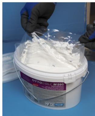
Nach dem Öffnen des Eimers den Beutel mit Trockenperlen entfernen und die Folie von einer Seite aus dem Eimer ziehen, ggf. Aushärtungen entfernen (nicht untermischen!). Falls der Klebstoff nicht komplett benötigt wird, Beutel mit Trockenperlen und Folie zum Wiederverschließen aufbewahren.
