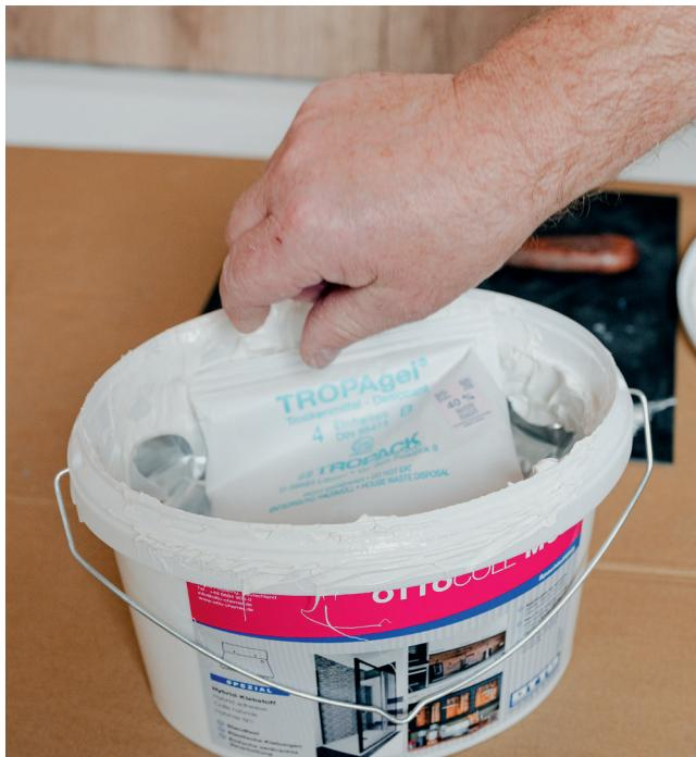
Для обеспечения повторного использования OTTOCOLL® M 595 требуется герметичное закрытие ведра. Для этого используйте шпатель, чтобы натянуть клей в небольшом подъеме в середине ведра и удалить любое закалывание. Поместите фольгу на клейкий материал и слегка прижимайте к краю. Затем сровняйте поднятую область в середине, чтобы удалить любые воздушные капли. Затем прижимайте фольгу к краю, вставьте сухие шарики и закройте ведро. OTTOCOLL® M 595 идеально закрыт для следующего применения.
