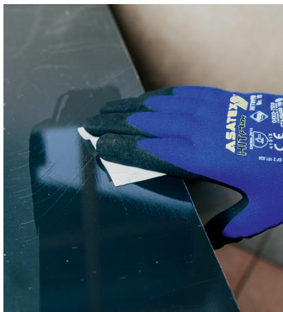
OTTOCOLL® M 595'in yapıştırılması için temel bir gereklilik, duvar yüzeyinin yük taşıma kapasitesidir. Gaz beton gibi emici yüzeyler söz konusu olduğunda, yük taşıma kapasitesi OTTOFLEX® Deep Primer ile ön işlem yapılarak da elde edilebilir. Sıhhi alanlarda, doğrudan OTTOFLEX® sıvı folyo üzerine yapıştırma mümkündür. İyi bir yapışma için temel ön koşul, yapıştırılacak malzemeler üzerinde yağsız ve tozsuz bir yüzeydir; bu da örneğin OTTO Cleaner T ile temizlenerek elde edilebilir.
