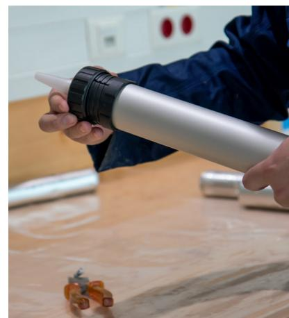
Voor de verwerking van OTTOCOLL® M 595 in alu foliezakken kan een hand- of accupistool worden gebruikt dat geschikt is voor foliezakken. Open hiervoor de alu foliezak, plaats de sputmond voor foliezakken erop en plaats de alu foliezak met sputmond in het pistool. Als alternatief kan de gewenste hoeveelheid lijm ook direct vanuit de foliezak worden aangebracht met behulp van een spatel. Vervolgens wordt het materiaal verder verwerkt met een getande spaan.
