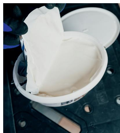
Nakon otvaranja kante, izvadite vrećicu s kuglicama za sušenje i izvucite film s jedne strane iz kante, uklanjajući sav stvrđnuti materijal ako je potrebno (nemojte ga miješati!). Ako ljepilo nije potrebno u cijelosti, ostavite vrećicu s kuglicama za sušenje i foliju za ponovno zatvaranje.
