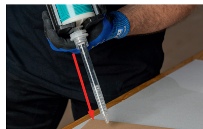
Napełnienie mieszacza statycznego klejem. Kontrola jednolitości mieszanki (patrz towarzyszące przygotowaniu kontrole jakości produktów 2-komponentowych)
