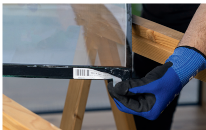
Retrait de l'autocollant du vitrage isolant
