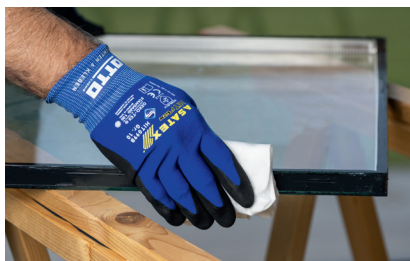
Nettoyage du mastic avec OTTO Cleanprimer (ou Cleaner + Primer) 1) et un chiffon en tissu
