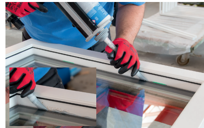
Remplissage de la feuillure avec l'adhésif
