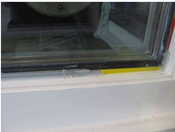
Bild 5 Glasfalz mit Dichtstoff
