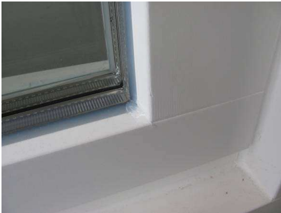
Bild 3 Äußere Verglasungsdichtung
