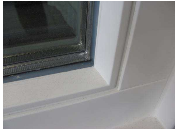
Bild 4 Innere Verglasungsdichtung
