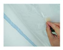
Fissare la barriera vapore con del nastro adesivo.
