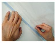
Formare un'ansa di compensazione nella barriera vapore, in modo che possa assorbire i movimenti dell'elemento costruttivo
