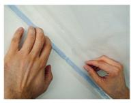
Formare una bretella di scarico nella barriera vapore, in modo che possa assorbire i movimenti dell'elemento costruttivo.
