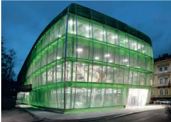
>>4: Das Haus für Musik und Musiktheater der Kunstuniversität Graz (kurz: MUMUTH; Architektur: UN Studio, Amsterdam) zeigt die faszinierende Wirkung der rundum horizontal auf allen Ebenen installierten Profilleuchten. (Bild: Paul Ott, © XAL)
