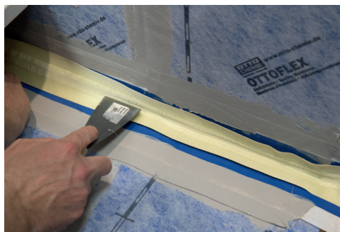
OTTOFLEX beschermingsband op de vloer plakken en aandrukken met de spatel.
