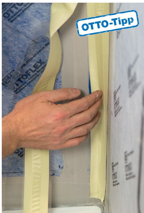
OTTOFLEX beschermingsband aan de kuip plakken
