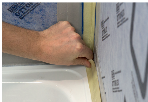
OTTOFLEX beschermingsband aan de kuip plakken
