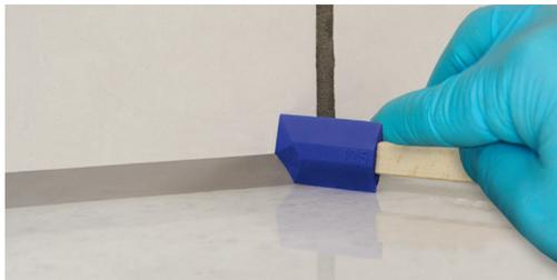
Le joint doit être réalisé de façon à ce que l'humidité ne puisse pas s'y accumuler ou y stagner (éviter les cannelures !).
