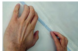
2. Former alors dans le film une boucle de soulagement qui absorbera les mouvements de la construction.
