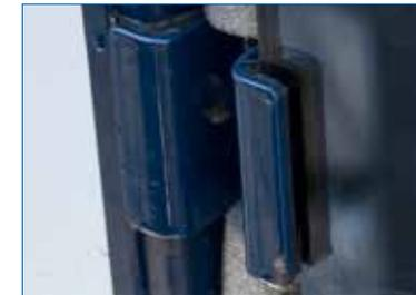
Sichtbare mechanische Sicherung MSS (Petschenig)
