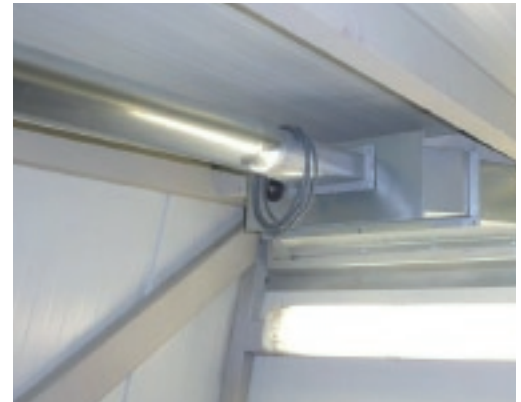
Erwärmte Luft wird mit einem Gebläse angesaugt und gesammelt.
