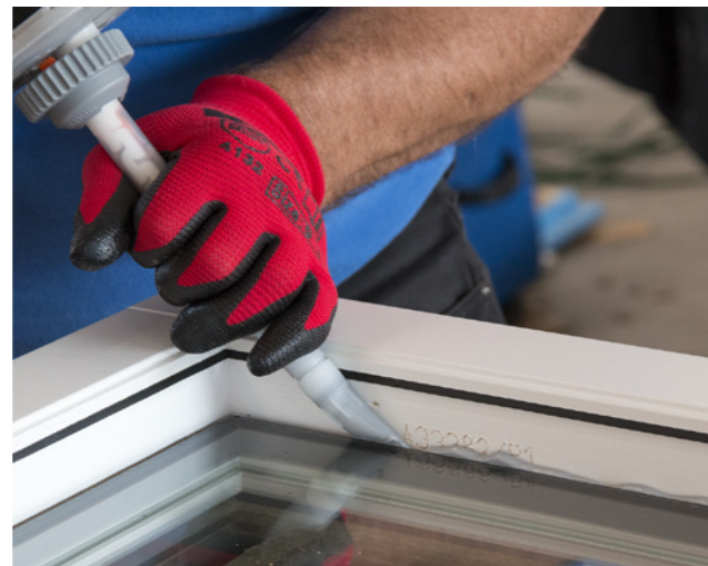
Manuelle Verarbeitung von OTTOCOLL® S81 mit der BlueLine Kartusche
