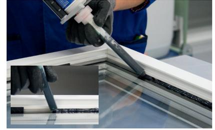
Befüllen des Falzgrundes mit Klebstoff
