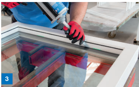
3 Befüllen des Falzgrundes mit Klebstoff
