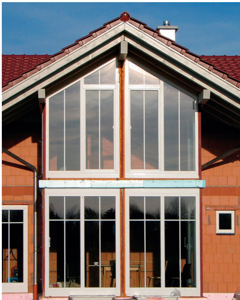
Abdichtung Baukörperanschluss mit spritzbaren Dichtstoffen OTTOSEAL® M360 bzw. OTTOSEAL® M361
