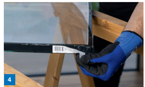
4 Entfernen von Aufklebern vom Isolierglas
