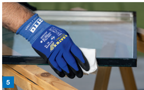
5 Reinigung des Randverbundes mit OTTO Cleanprimer (bzw. Cleaner + Primer) 1) und Stofftuch
