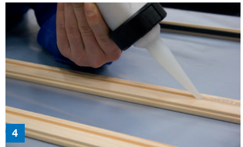
4 Oder: Abdichtung zwischen Flügelrahmen und Glashalteleiste flächig
