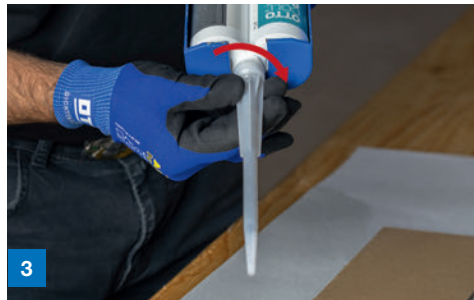
3 Material abwischen und Statikmischer aufschrauben
