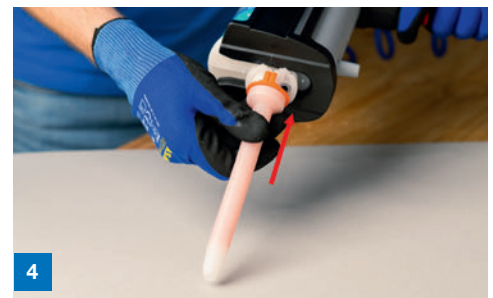
4 Material abwischen und Statikmischer aufsetzen
