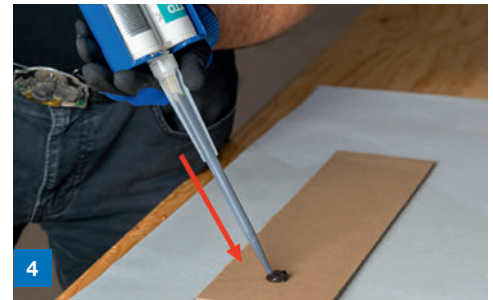
4 Befüllen des Statikmischer mit Klebstoff und Homogenität der Mischung prüfen (siehe Verarbeitungsbegleitende Qualitätskontrollen 2K-Produkte)
