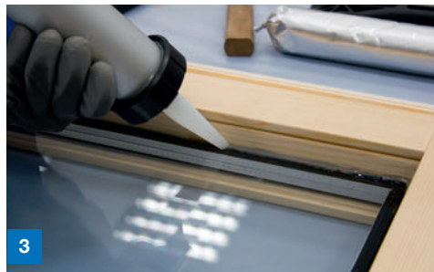
3 Abdichtung zwischen Flügelrahmen und Glashalteleiste auf Position 4
