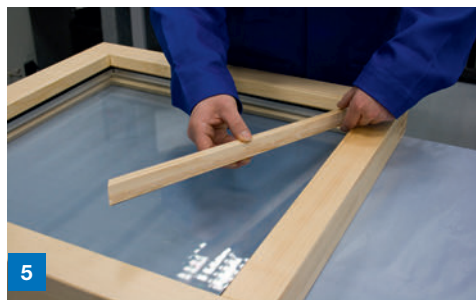
5 Einbringen der Glashalteleiste
