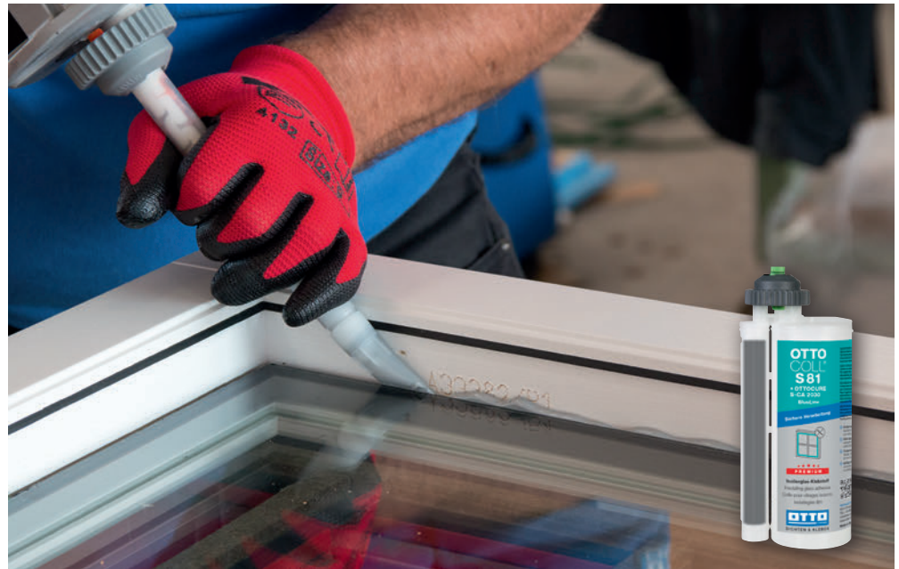
Manuelle Verarbeitung von OTTOCOLL® S81 mit der BlueLine Kartusche.
