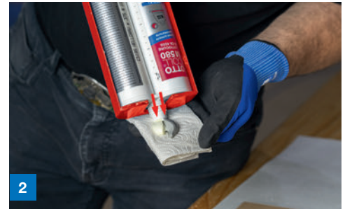
2 Material ohne Statikmischer ausdrücken, bis aus beiden Öffnungen Material austritt
