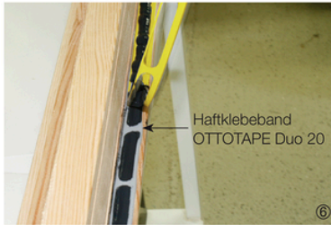
6. Entfernung des Liners
