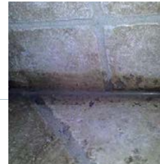
Falscher Dichtstoff: die Siliconöle drangen in den offenporigen Naturstein, hier Travertin, ein.
